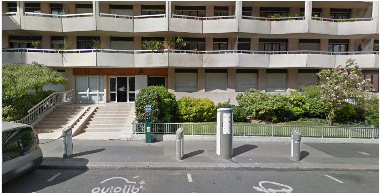
Rue Vauvenargues, Paris
